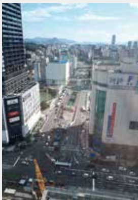
JR広島駅、南口再整備
