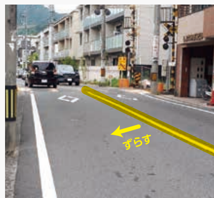
歩道の改善が検討されている油谷踏切付近の道路
